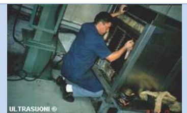
Preparazione e montaggio impianti ad ultrasuoni
